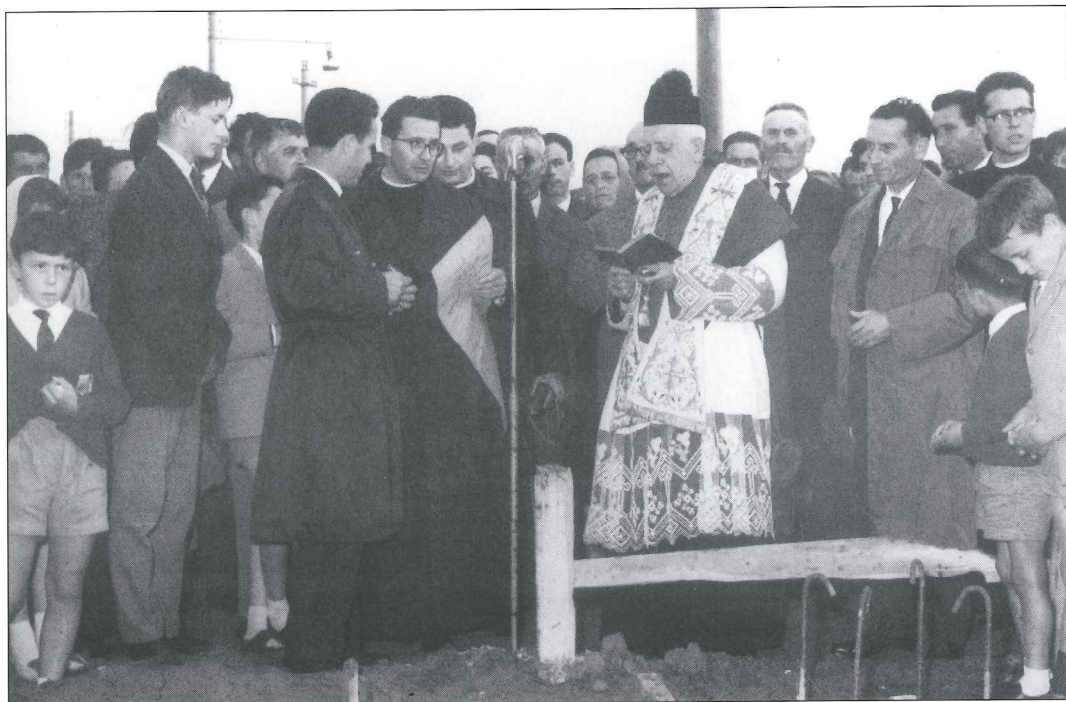
Posa della prima pietra dell'edificio delle A.C.L.I.
